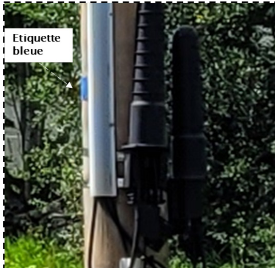
Equipements cuivre et poteaux réinstallés
