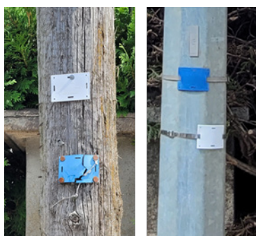
Réseau Syndicat mixte sur poteau Orange après 2018 étiquette blanche (Syndicat mixte) + étiquette bleue (identification Orange)
