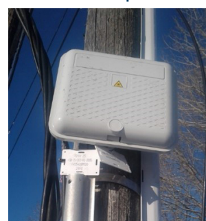
Boîtier optique posé par le SMIX sur un poteau (étiquette blanche)
