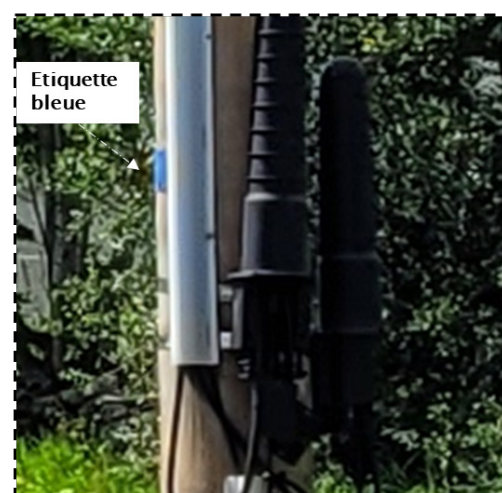
Équipements cuivre et poteaux réinstallés
