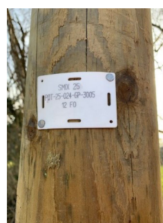
Poteau implanté par le SMIX et identifié avec une étiquette blanche
